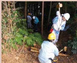
丸太階段の設置 H16年12月
