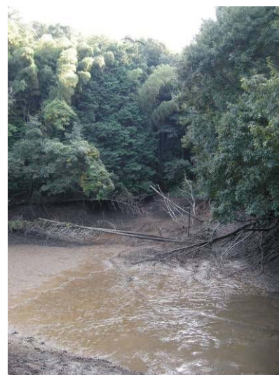
■ため池周囲の森林においても、維持管理不足に伴い、ため池内への倒木、水際の浸食が見られる。
